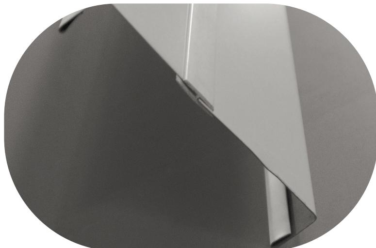
При монтаже сэндвич-панелей на пол необходимо учитывать сторону панелей, лицевой стороной вверх. Лицевая сторона промаркирована на панелях. Панели для пола и потолка должны точно соответствовать одному из поперечных размеров камеры (внешнему или внутреннему) либо по длине, либо по ширине. Вариант укладки указывается на сборочном чертеже. Вертикальные углы камеры заделывают металлическими уголками, обычно совпадающими по цвету с наружной поверхностью стеновых панелей.
