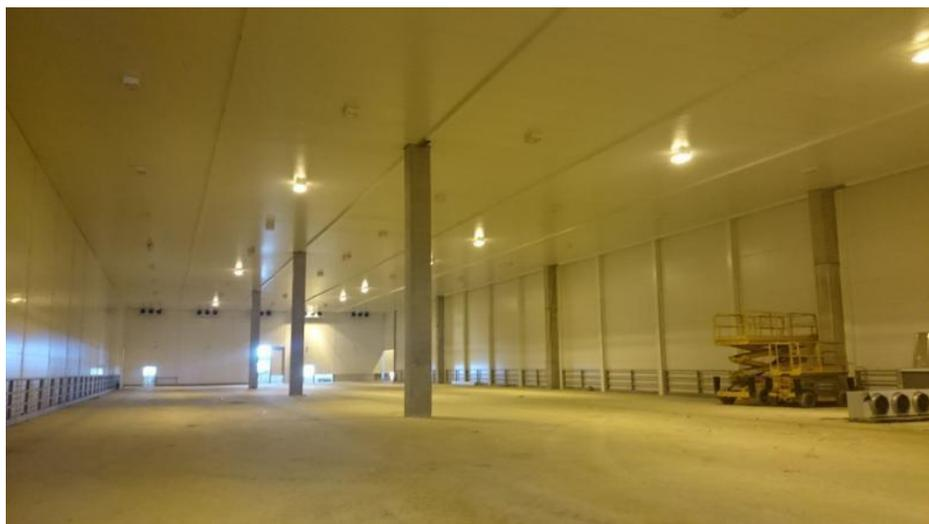
Рисунок 1: Холодильный склад. Панели производства ПрофХолод использованы в качестве стен и потолка
